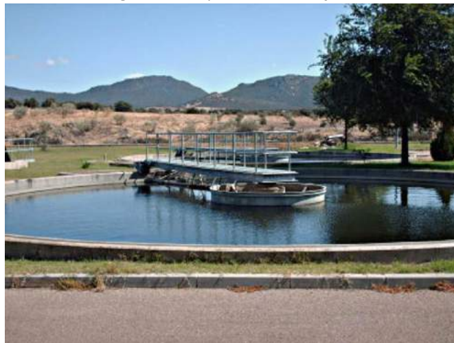
Figura 22. Tanque de sedimentação.
