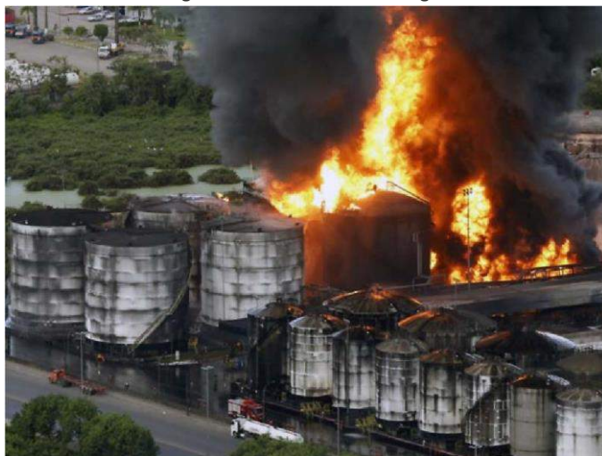
Figura 7. incêndio da ultracargo.
